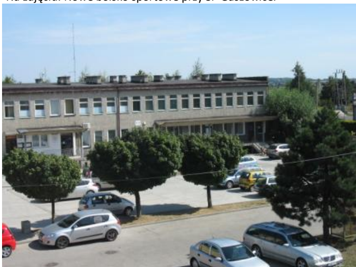
Na zdjęciu: Przebudowany parking w centrum Gaszowic.
