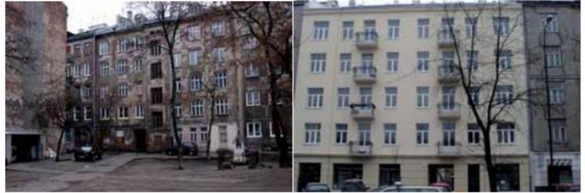
Fot. 4.3. Kamienica przy ul. Żąbkowskiej 36 przed remontem i po remoncie Źródło: www.um.warszawa.pl
